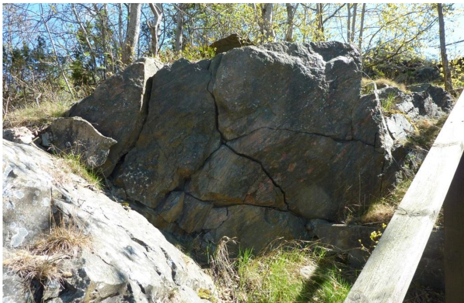
Foto 7. Sprängningsarbetena har medfört ogynnsam sprickbildning och lutning.
