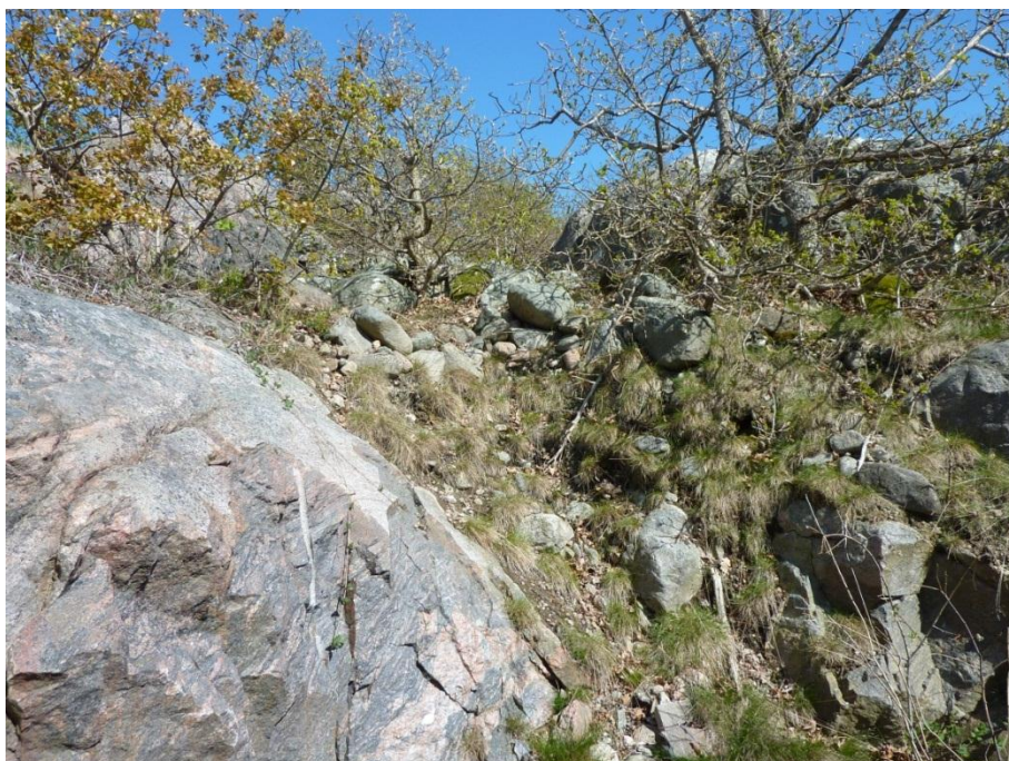
Foto 13. Lösa block och stenar ligger uppe på släntkrönet.
