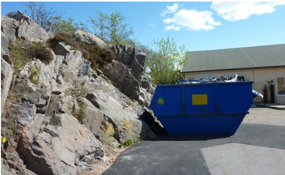
Foto 12. Bergskärningen lutar in mot bebyggelsen och berget är uppsprucket.
